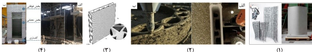
تصویر ۱. ۱. نمونه دیوار مسلح چاپ سه‌بعدی شده. مأخذ: Alim-Khan et al., 2021 / ۲. الف دیوار چاپ سه‌بعدی بتنی، ب دیوار چاپ سه‌بعدی کاهگل. مأخذ: Alhumayani et al., 2020 / ۳. سیستم دیوار با مقطع سینوسی. مأخذ: Kuzmenko et al., 2019 / ۴. الف حمام پیش ساخته با قالب فولادی، ب حمام چاپ سه‌بعدی بتنی. مأخذ: Wang et al., 2014.
