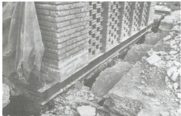
تصویر ۵. کلافکشی بنای عالی‌قاپوی اصفهان در دهه ۴۰ توسط مؤسسه ایزمئوی ایتالیایی. مأخذ: زاندر، ۱۳۹۶، ۳۲۲.
