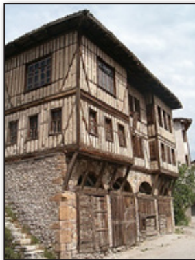
تصویر ۴. قاب‌بندی چوبی و مصالح پرکننده. مأخذ: Midilisari, 2011:785.
