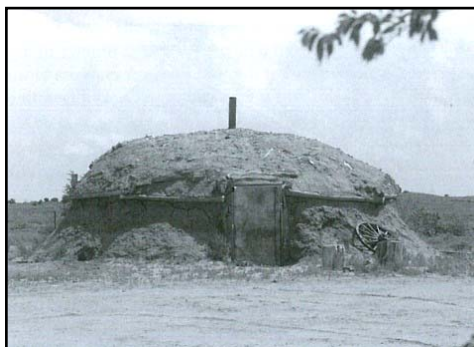
تصویر ۱۷. کلبه‌های ناواجو با دیوارهای ضخیم خاکی در جنوب غرب ایالات متحده در اقلیم گرم و خشک راحتی را به وجود آورده‌اند، مأخذ: lechner, Niky:251.
