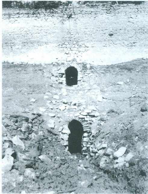
۷. خروجیهای آب در ارتفاعات مختلف بر روی بدنه سد
