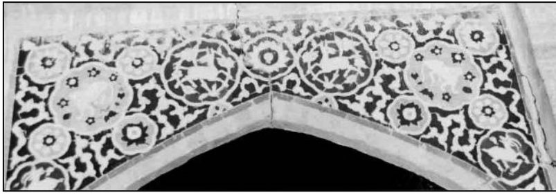
تصویر ۱۴. کاشیکاری معرق با نقوش گیاهی و هندسی (ترنجه‌ها). حیاط کاروانسرا. ضلع شمالی طبقه پایین.
