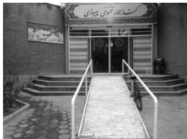
تصویر ۶. عدم دسترس پذیری ساختمان‌های عمومی به دلیل نامناسب بودن سطح شیب‌دار. عکس: ندا رفیع‌زاده، ۱۳۹۵.
