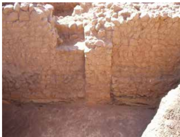
تصویر ۵. شالوده بخشی از دیوارهای ساختار معماری معروف به گرمابه ربع رشیدی بر روی لایه خاک‌روبه و مزبله نهاده شده است. مأخذ: نگارندگان.
