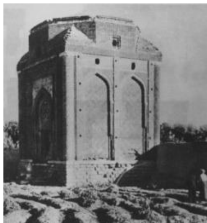
تصویر ۵-ب. نمای بیرونی گنبد سرخ و نمایش منطقه انتقال آن در قالب منشور هشت پهلوئی مستقر بر روی چهاردیواری گنبدخانه. عکس از اندره گدار.
