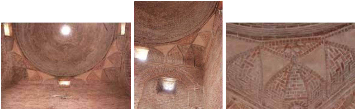
تصویر ۵-الف. منطقه انتقال گنبد سرخ و نحوه گوشه‌سازی‌ها، دید از داخل. عکس: حجت گلچین.
