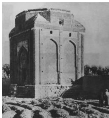
تصویر ۵-ب. نمای بیرونی گنبد سرخ و نمایش منطقه انتقال آن در قالب منشور هشت پهلو مستقر بر روی چهاردیواری گنبدخانه. عکس از اندره گدار.
