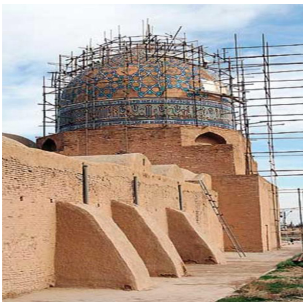
تصویر ۴. نصب دیوار پشت بند مسجد جامع ساوه. عکس: ابویی، رضا، ۱۳۹۵.
