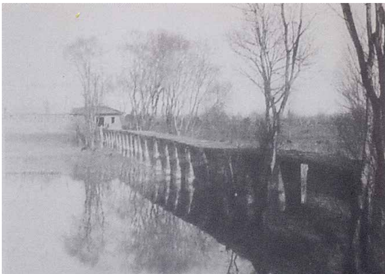
تصویر ۵. پل چوبی بحرالارم در سال ۱۲۷۰ش؛ متشکل از ۲۹ پایه سنگی و کف چوبی که تنها معبر دسترسی به دریاچه بوده و در امتداد خیابان منتهی به سبزه میدان واقع بود. مأخذ: الهی، ۱۳۸۵: ۱۹.
