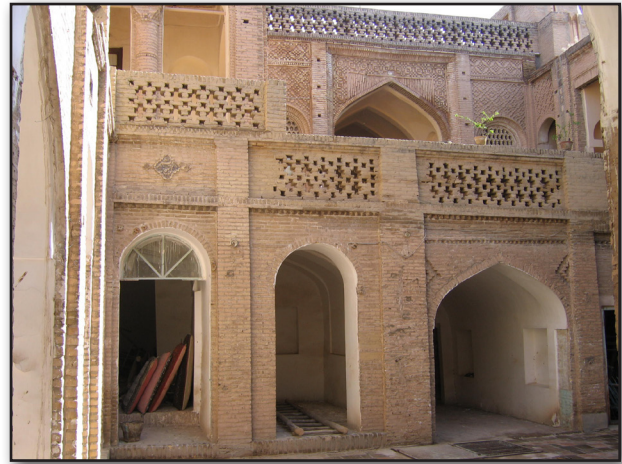
تصویر ۳. افزایش سطح سایه‌گیری جداره‌ها در معماری سنتی دزفول با استفاده از آجرکاری تزئینی. مأخذ: آرشیو محسن تابان..
