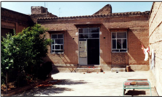
تصویر ۱. جداره‌های حیاط مرکزی نمونه گروه ج. مأخذ: آرشیو محسن تابان. Fig.1. Central courtyard walls of Group C. Source: Mohsen Taban's archive.
