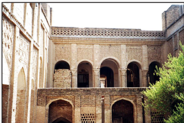
تصویر ۲. افزایش سطح سایه‌گیری جدارها در معماری سنتی دزفول با استفاده از طاق‌نماهای تزیینی. مأخذ: آرشیو محسن تابان.
