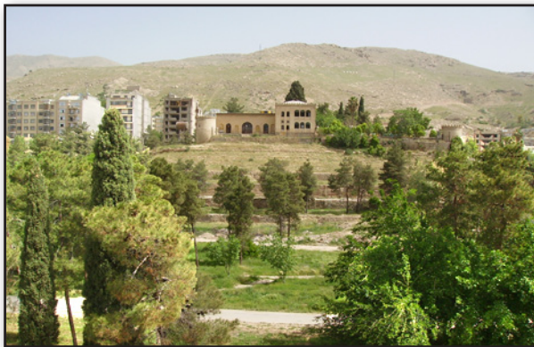
تصویر ۴. دورنمایی از وضعیت فعلی باغ. عکس: ندا عرب سلغار، ۱۳۸۹. Fig4. A view from the current status of "Baghe Takht" garden. Photo: Neda Arabsolghar, 2010.
