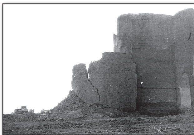
تصویر ۹. تخریب دیوار شرقی جبهه شمالی ارک تبریز در سال ۱۳۶۰ ه.ش. مأخذ: آرشیو آقای علی اکبر سرفراز. Fig. 9. Destruction of the eastern wall situated in the northern façade of the Arch of Alishah in Tabriz in 1981. Source: The personal archive of Ali akbar Sarfaraz.
