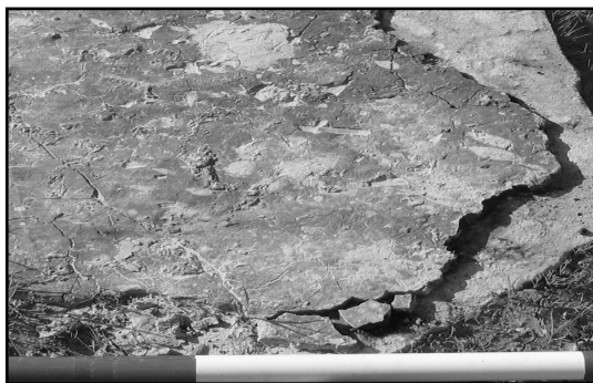
تصویر ۹. استفاده از قیر طبیعی به منظور ایزوگام سقف در کاخ برازجان. مأخذ: نگارندگان
